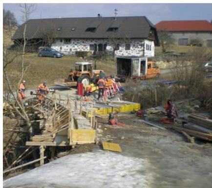
Mit der geringfügigen Veränderung des Brücktragwerkes wird das Einfahren vom Güterweg Seiser in das neue Siedlungsgebiet „Kranzlbauer II“ wesentlich erleichtert, bzw. brauchen entlang des Güterweges Seiser keine gravierenden Böschungseinschnitte durchgeführt werden.
